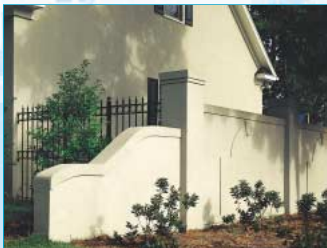
Mur de jardin, USA
